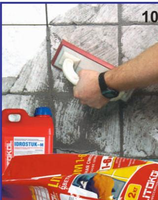
Заполните межплиточные швы цветной затирочной смесью на основе цемента **LITOCHROM 1-6/3-15** смешанной с латексом **IDROSTUK-м**. Затирку наносите по диагонали относительно направления швов резиновой теркой.
