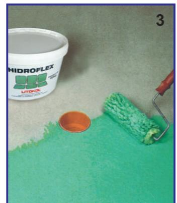
Нанесите на пол кистью, валиком или шпателем первый слой гидроизоляционной мастики **HIDROFLEX**.
