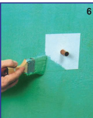
Нанесите второй слой **HIDROFLEX** на пластирь **LITOBAND S** вокруг выпусков труб из стены.
