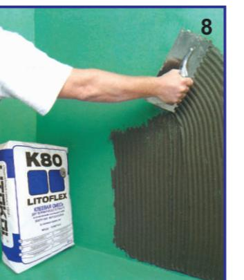
Облицовочные работы можно начинать после полного высыхания второго слоя **HIDROFLEX**. Нанесите клей **LITOFLEX K80**, **LITOPLUS K55**, **SUPERFLEX K77** или **LITOSTONE K98/K99** (в зависимости от условий) зубчатым шпателем.
