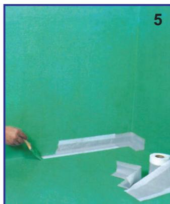
Через 2 часа нанесите второй слой **HIDROFLEX** валиком или гладким стальным шпателем на всю гидроизолированную поверхность, в том числе на гидроизоляционную ленту **LITOBAND R** и угловые элементы **LITOBAND AI/AE**.
