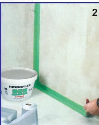
Для герметизации углов и стыков между стеной и полом нанесите кистью гидроизоляционную мастику **HIDROFLEX**. Сразу на свежий слой **HIDROFLEX** приклейте гидроизоляционную ленту **LITOBAND R** и угловой элемент **LITOBAND AI**.
