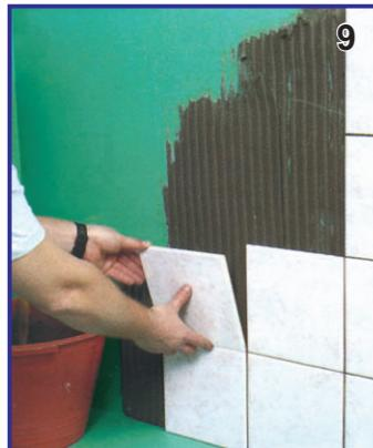
Уложите плитку на клеевой слой, нанесенный на гидроизоляцию. Обратная сторона плитки должна быть полностью покрыта клеем.
